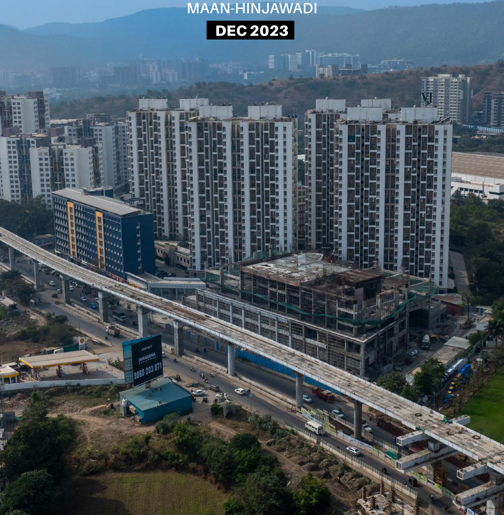
ACTUAL DRONE PHOTO OF SITE
